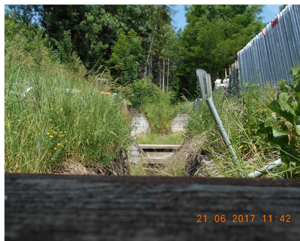
Dissabbiatore posto prima dell'interramento del corso
