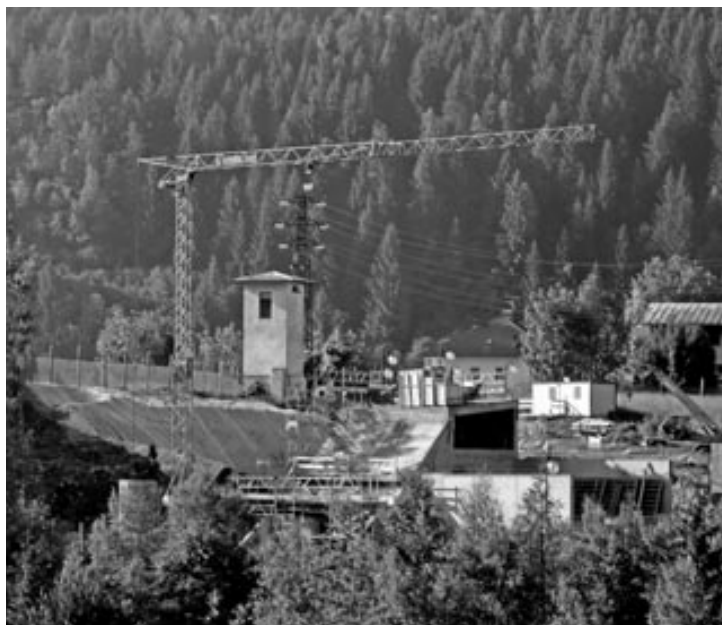
Nuovo polo scolastico in costruzione
