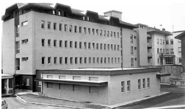
› L'ampliamento del 1974 con in primo piano il Poliambulatorio e l'ingresso del nuovo Pronto Soccorso
