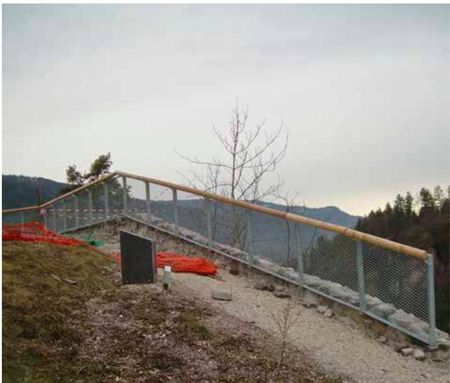
L'attuale percorso di accesso al complesso realizzato negli anni 70 del secolo scorso, a est della torre, formato da lastre di porfido cementate, attualmente molto deteriorate e spaccate in più punti sarà dismesso senza smantellare la sezione stradale e coperto con uno strato di terreno vegetale in modo da stabilire una continuità con il manto erboso esistente, sarà comunque possibile accedere in casi eccezionali al "dosso" con mezzi a motore.
