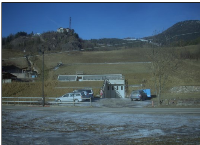
Foto dell'attuale magazzino
