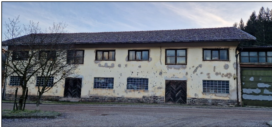
Capannone produttivo ditta edile in loc. Cascata
