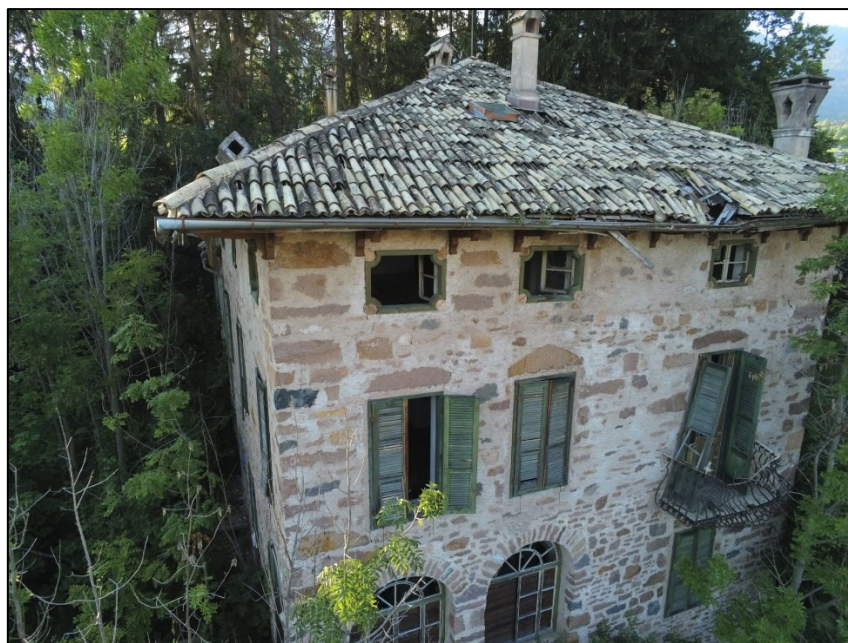
Villa Covi (vista da sud est)
