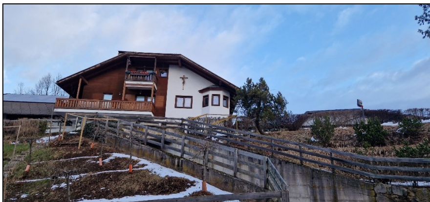
Foto dell'edificio sottostante la p.ed.1630
