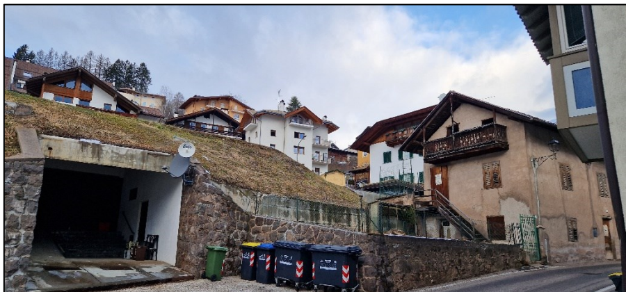
Foto dalla strada sottostante il lotto
