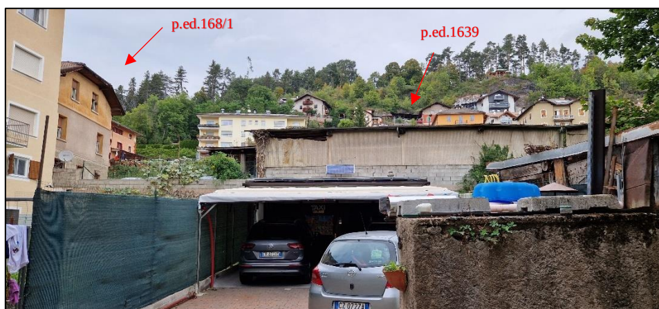
Area compresa nel PRU3 vista da valle (via Pizzegoda rimane a monte)
