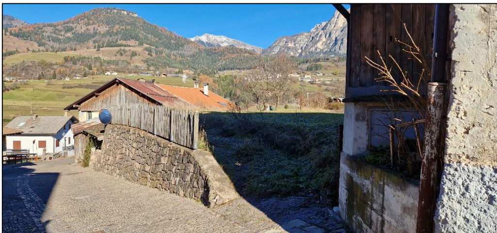
Il parcheggio verrà realizzato demolendo, arretrando di circa 6 metri e rifacendo il muro in foto.
