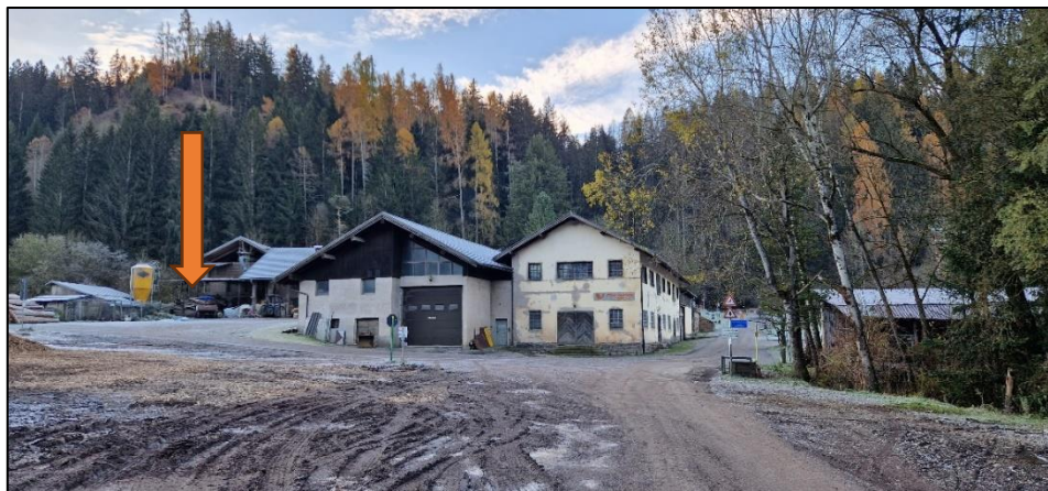
Foto loc. Cascata: la freccia sta a indicare l'area di Variante n.81 ( a fianco dell'edificio di Var.46)
