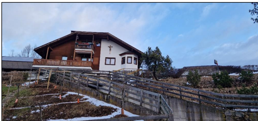
Foto dell'edificio sottostante la p.ed.1630
