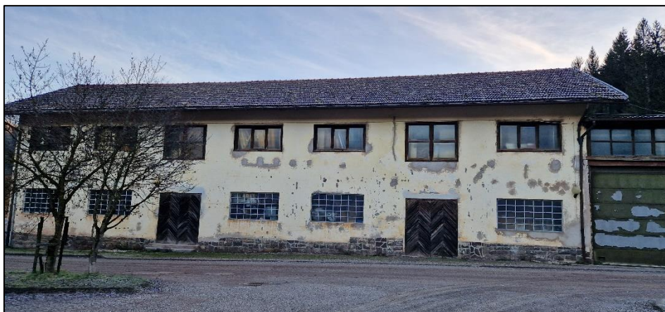
Capannone produttivo ditta edile in loc. Cascata
