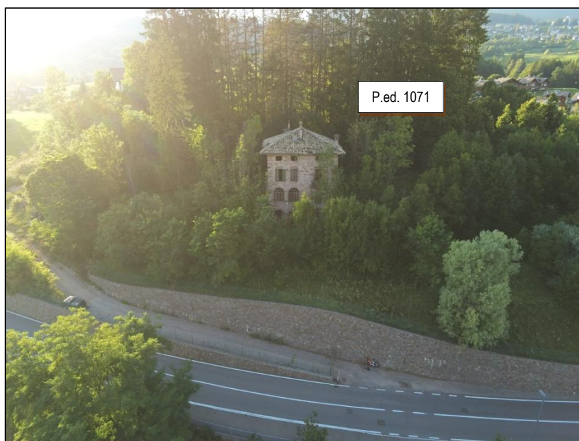
Documentazione fotografica (vista da est)
