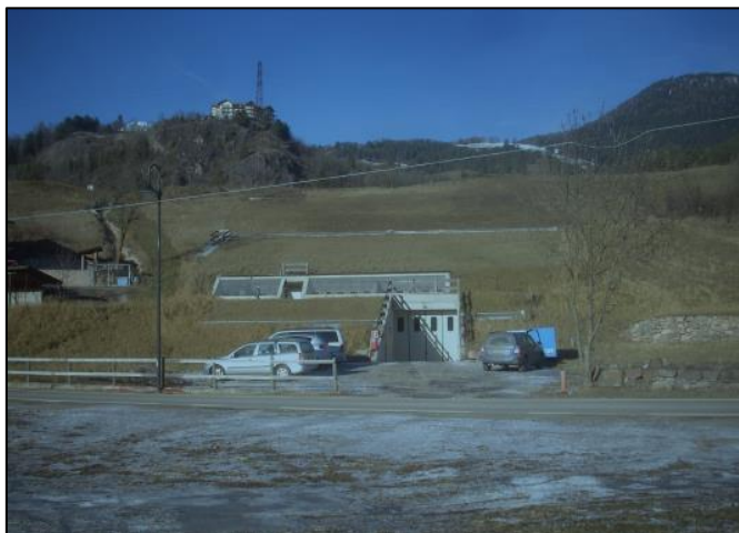
Foto dell'attuale magazzino edile -da sud
