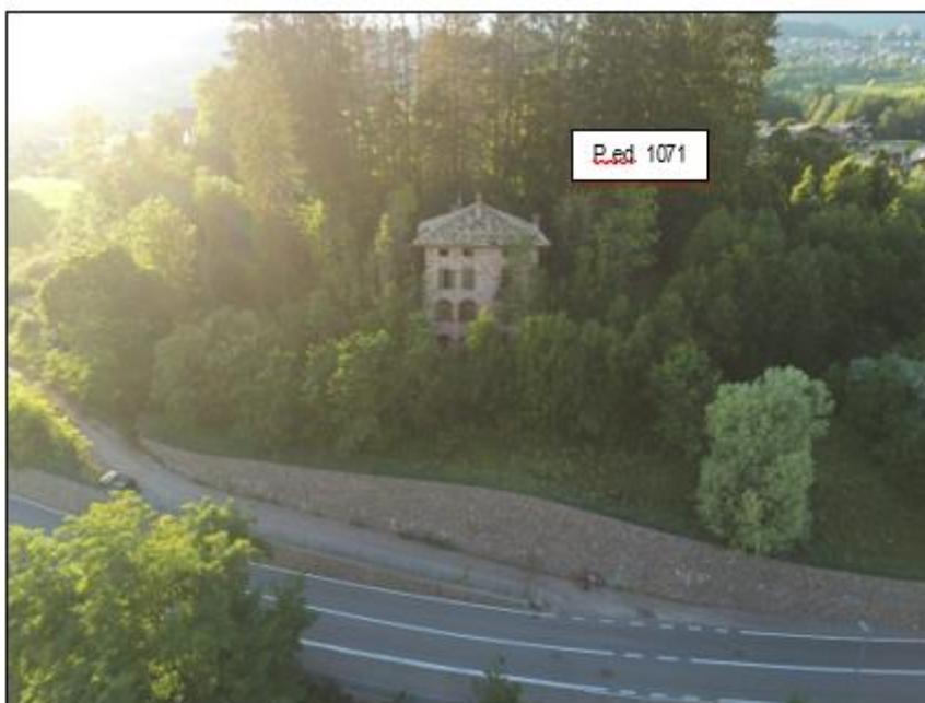
Documentazione fotografica (vista da est)
