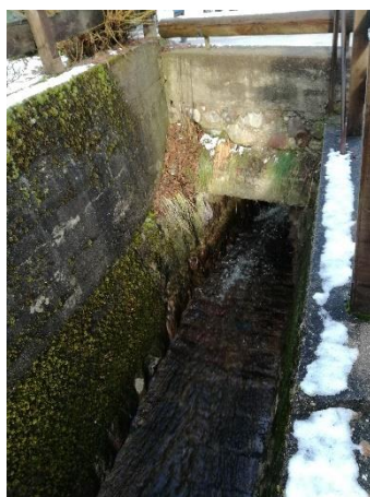
Figura 64: Rio Arizzol – A sinistra: cunettone e inizio del tratto tombinato per l'attraversamento di via chiesa. A destra: canaletta prefabbricata che fa defluire le acque del rio Arizzol nell'ultimo tratto prima della confluenza con il torrente Avisio. Il corso d'acqua in questo tratto è pensile.
