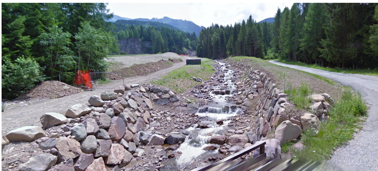
Figura 15: Rio Val della Roda – Vista del tratto a monte dell’attraversamento della strada che porta a Malga Salanzada dopo i lavori di sistemazione idraulica nel giugno 2011 (fonte: Google Street View).
