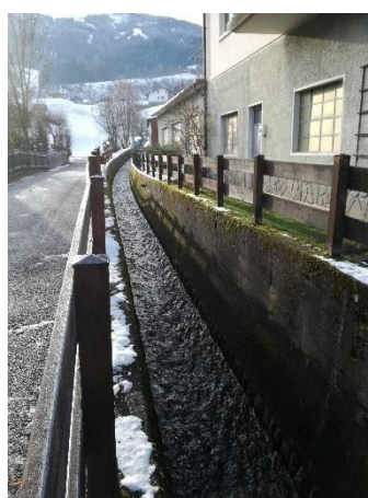
Figura 63: Rio Arizzol – A sinistra: cunettone e ponte in cemento armato per l'attraversamento di via Gianarde. A destra: cunettone nel tratto che attraversa il centro abitato di Masi di Cavalese e termina con l'attraversamento di via Chiesa.
