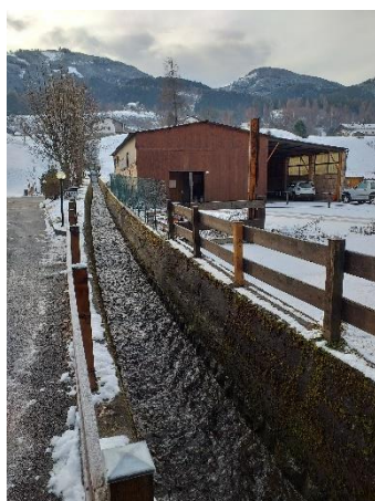
Figura 68: Rio Arizzol – a sinistra: vista del del cunettone in cemento armato nel tratto che attraversa il centro abitato di Masi di Cavalese, a monte dell'attraversamento di via Chiesa; a destra: vista del tratto terminale della cunetta prefabbricata.
