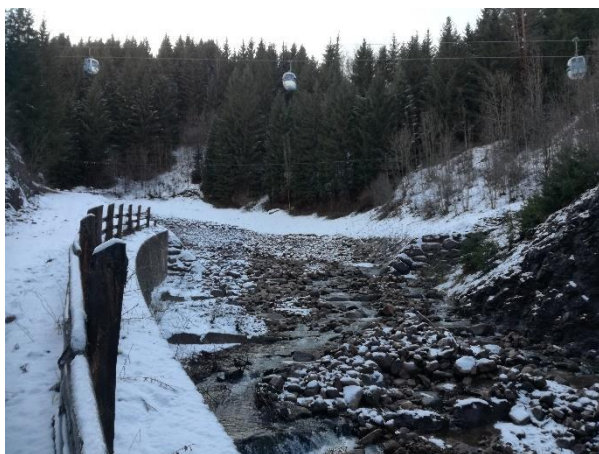
Figura 20: Rio Val della Roda – Immagini al punto 3: Il tratto compreso tra la curva e la briglia filtrante presenta depositi di materiale solido in alveo, ma di modesta entità.
