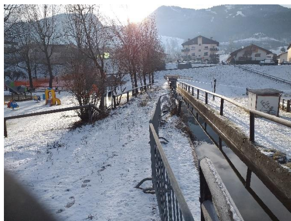
Figura 68: Rio Arizzol – a sinistra: vista del del cunettone in cemento armato nel tratto che attraversa il centro abitato di Masi di Cavalese, a monte dell'attraversamento di via Chiesa; a destra: vista del tratto terminale della cunetta prefabbricata.
