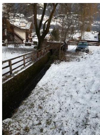
Figura 62: Rio Arizzol – A sinistra: cunettone e tombotto di attraversamento di via Pizzoni. A destra: cunettone e attraversamento per l'accesso alle abitazioni di via Pizzoni.
