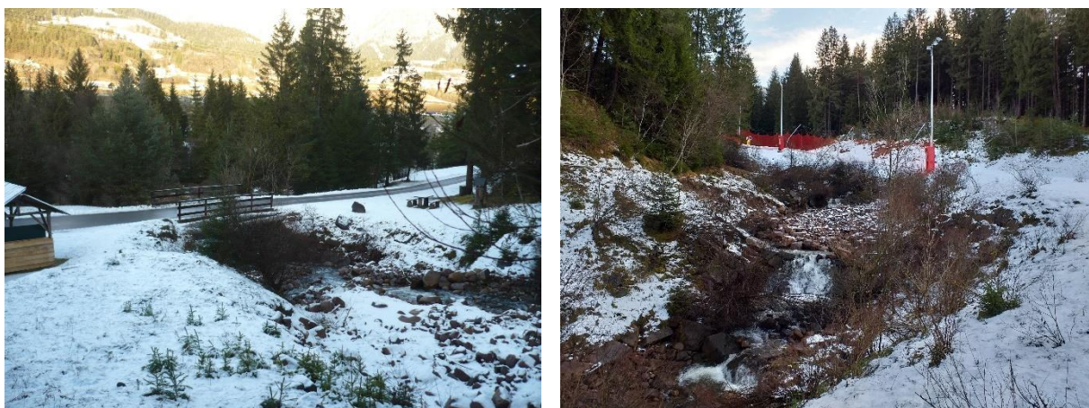
Figura 14: Rio Val della Roda – a sinistra: attraversamento della pista ciclabile delle Valli di Fiemme e Fassa; a destra: briglie di consolidamento presenti a monte dell’attraversamento della pista ciclabile.
