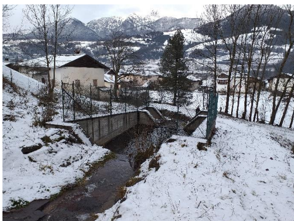
Figura 70: Rio Arizzol – A sinistra: vista della vasca di sedimentazione; a destra: lieve incisione che fa defluire le acque dell’affluente destro fino alla tubazione che convoglia le acque nel corso principale a seguito di un percorso non bene definito.
