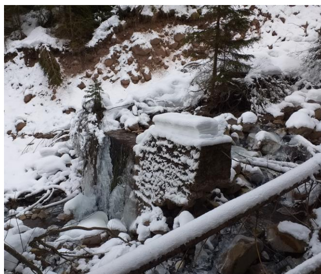
Figura 9 Tratto rappresentativo per T04b (foto di sinistra) con briglia sospesa danneggiata per erosione delle sponde (foto di destra)
