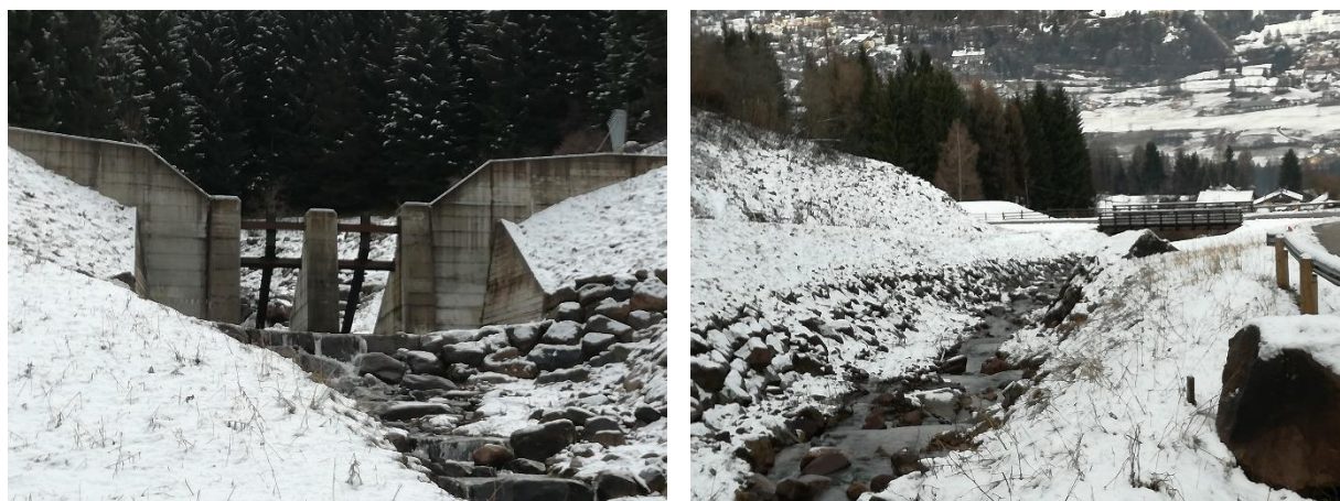
Figura 60: Rio Arizzol – a sinistra: briglia filtrante e briglie di consolidamento; a destra briglie di consolidamento presenti a valle della briglia filtrante.
