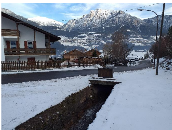
Figura 62: Rio Arizzol – A sinistra: cunettone e tombotto di attraversamento di via Pizzoni. A destra: cunettone e attraversamento per l'accesso alle abitazioni di via Pizzoni.
