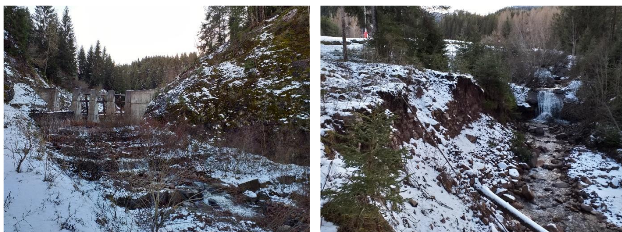
Figura 13: Rio Val della Roda – a sinistra: briglia filtrante e briglie di consolidamento; a destra briglie di consolidamento presenti a valle dell’attraversamento della strada che porta a Malga Salanzada.
