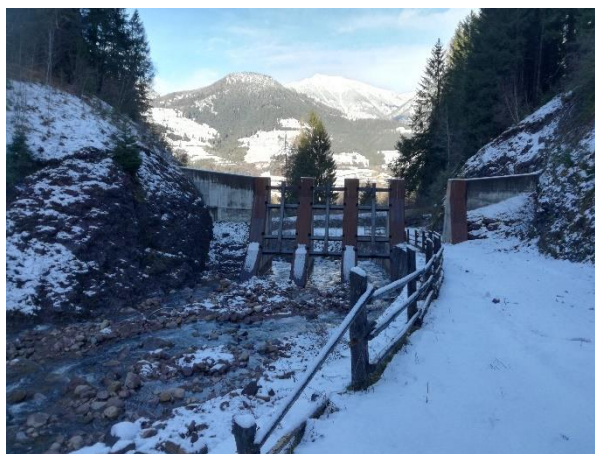
Figura 20: Rio Val della Roda – Immagini al punto 3: Il tratto compreso tra la curva e la briglia filtrante presenta depositi di materiale solido in alveo, ma di modesta entità.
